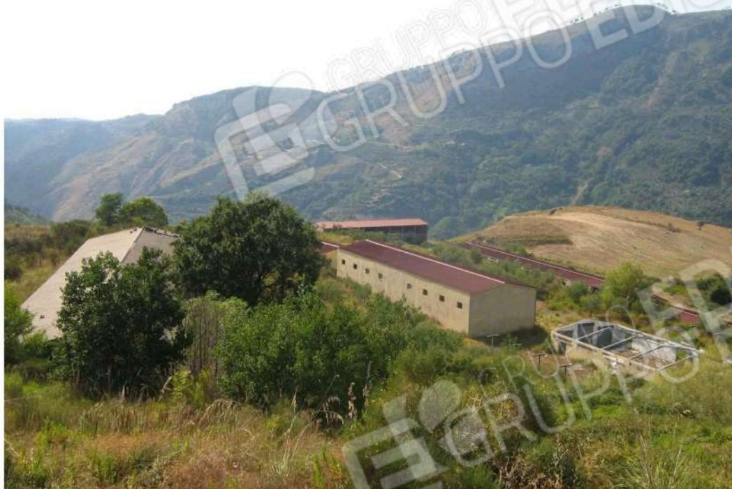
Foto n. 5: foto prospettiva lotti n. 3 e n. 4 ubicati nel comune di Martirano Lombardo.
