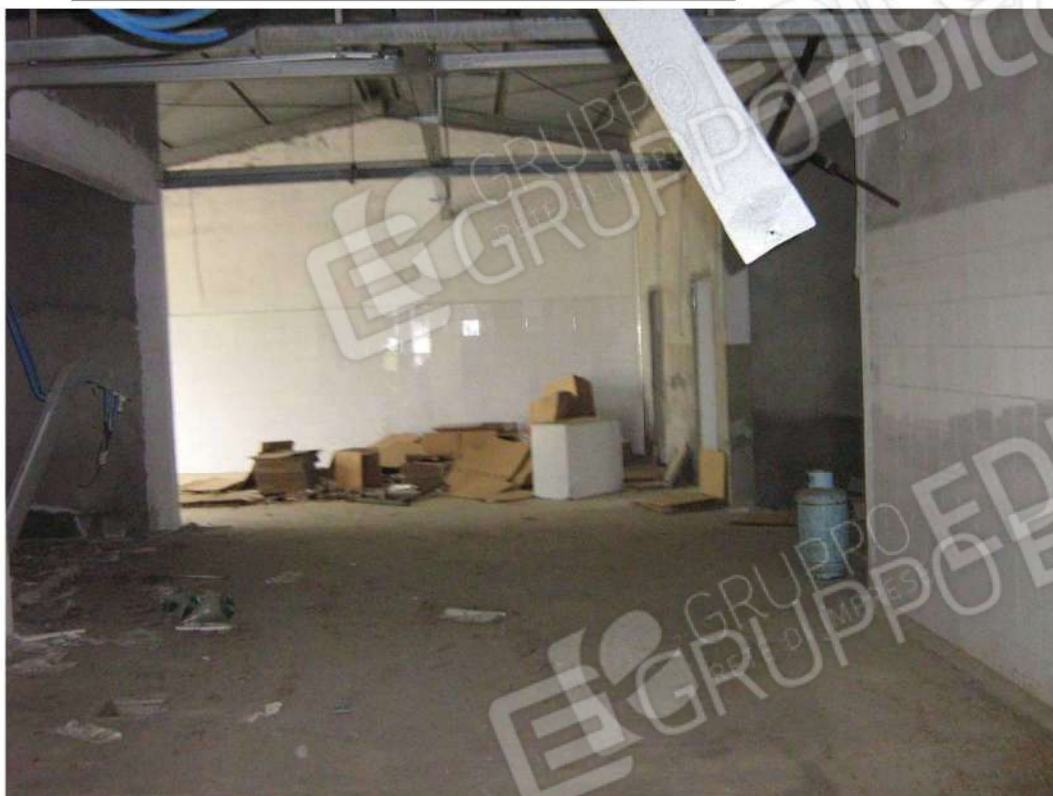
Foto n. 59: particolare ambiente interno - Fabbricato "C" (lotto n. 4).
